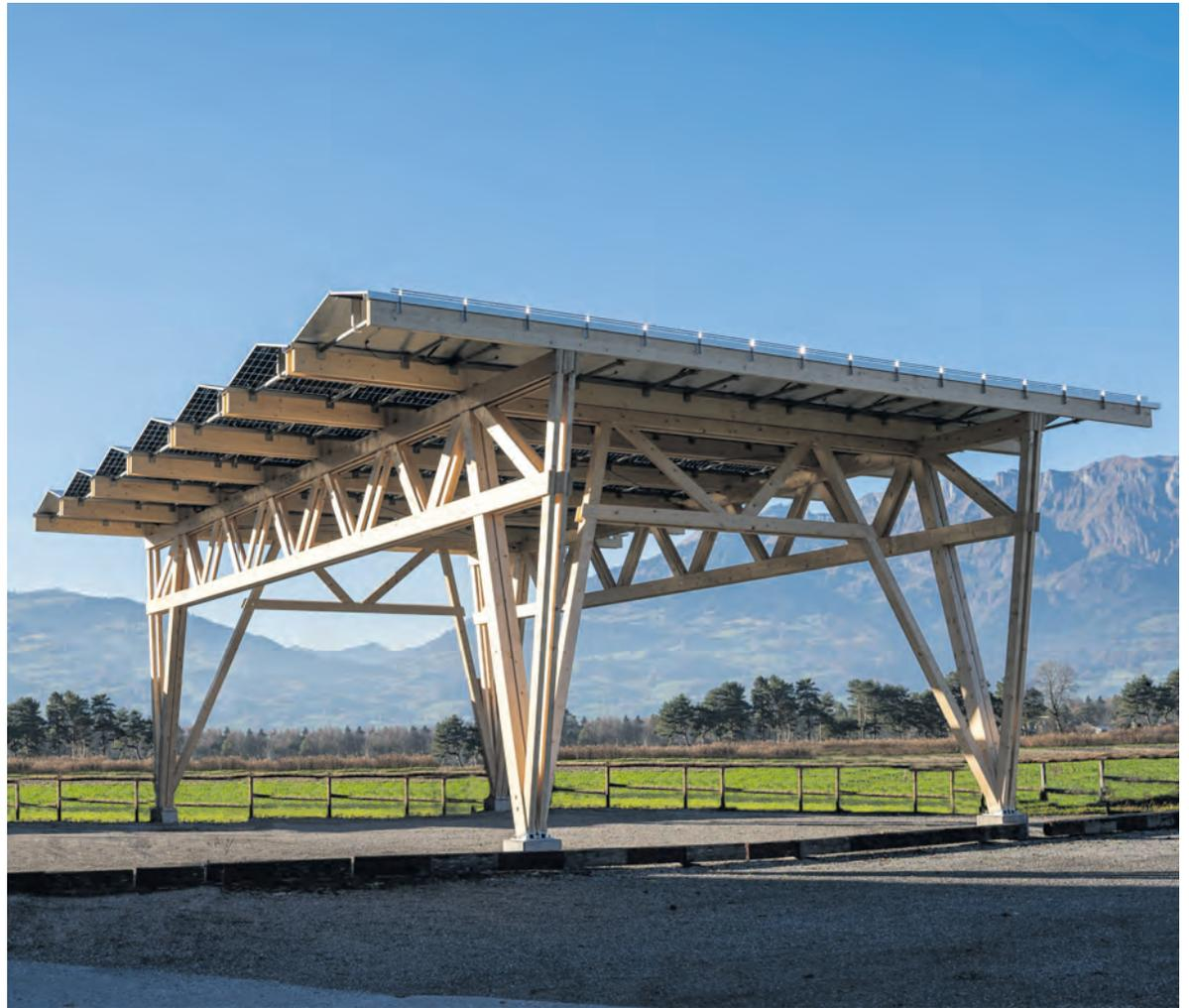
Die Firma iWorks aus Ruggell hat Urbanbox entwickelt. Damit sind Flächen für die Solarstromproduktion nutzbar, bei denen sehr grosse Spannweiten bis 40 Meter eine Voraussetzung sind.
